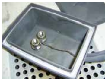
Soudobrasage dans caisson de mise sous gaz
