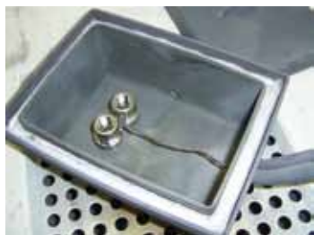
ガスバージボックス内での硬ロウ付け
